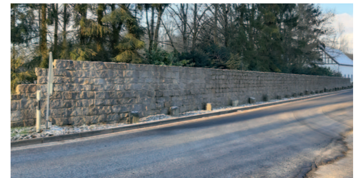
Grundstücksabgrenzung mit Bruchsteinen
