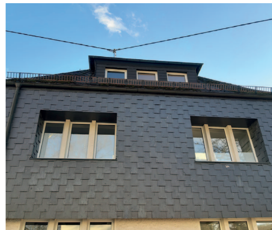
Fassade und Dach sind mit Schiefer eingedeckt
