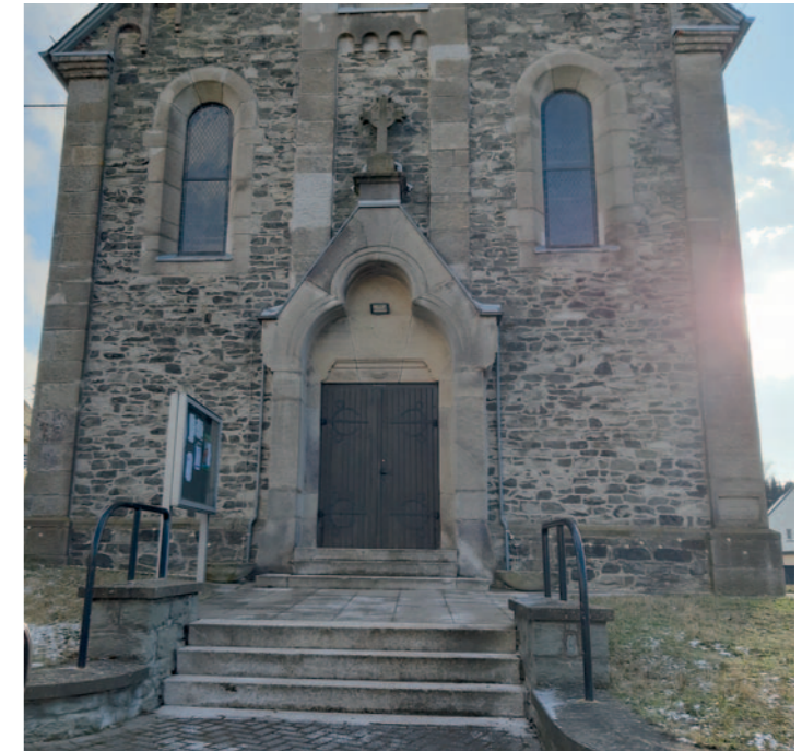
Die 1903 erbaute Kirche in Oberahr, gemauert aus Bruchsteinen
