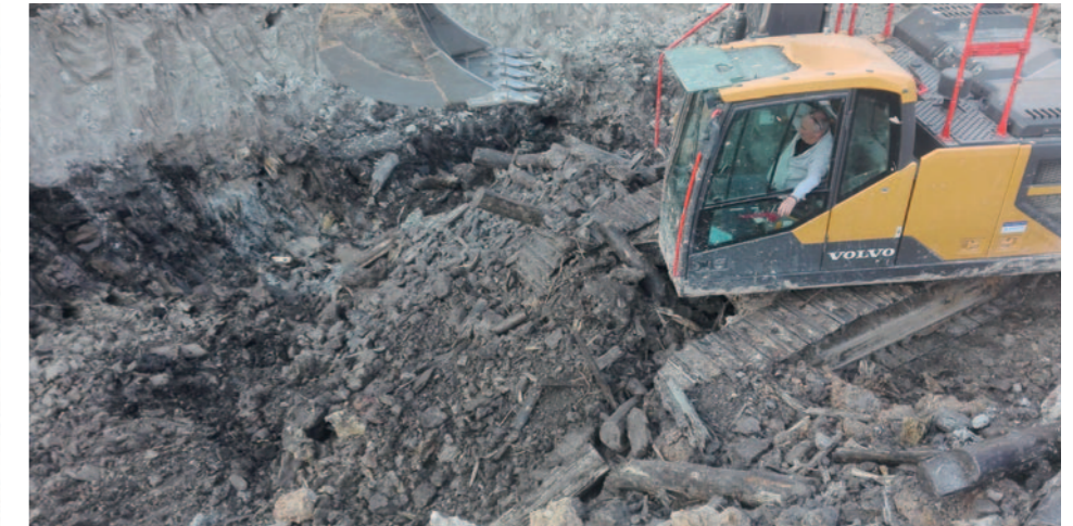
Nach Jahrzehnten wieder an der Oberfläche: »Tonholz« verbaut in den 1930er Jahren
