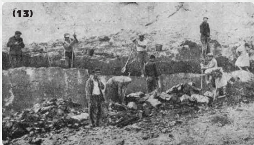
(13) Tonstecher in einer Grube bei Chasov Yar. Originalunterschrift: "Mining fireclay before the revolution", Quelle: Ogneupory No.8, 1967
