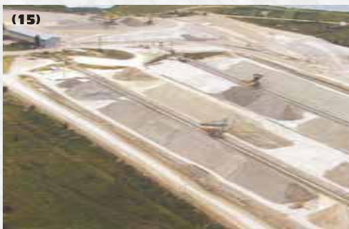
(15) Mischanlage der UMG-Firma Vesco, Drushkovka, mit 500 m-langen Förder- und Absetzbändern (15). Hier können mehrere hunderttausend Tonnen für die Wintermonate bevorratet werden, wenn der Abbau in den Gruben planmäßig eingestellt wird.
