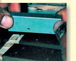
Messpunkte für die Schwindungsmessung werden auf die Oberfläche gesetzt
