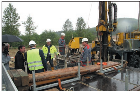
Das Bohrgerät der Sibelco Deutschland GmbH im Einsatz
