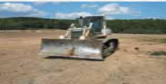
Verfüllung einer ausgetonten Grube mit Erdaushub (Bild A. Ertel)
