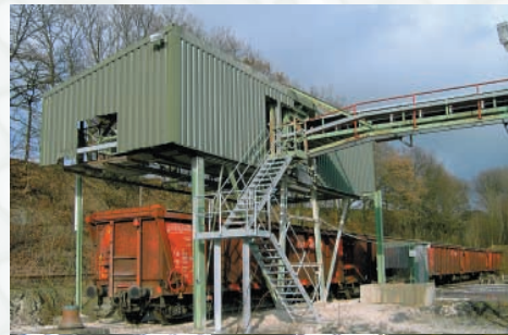
Zur Direktbeladung von Tonwaggons entwickelter Beschicker, Grube Pfeul, Niederahr
