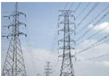
Isolatoren an Hochspannungsleitungen (Quelle: Westerwälder Tonkiste)
