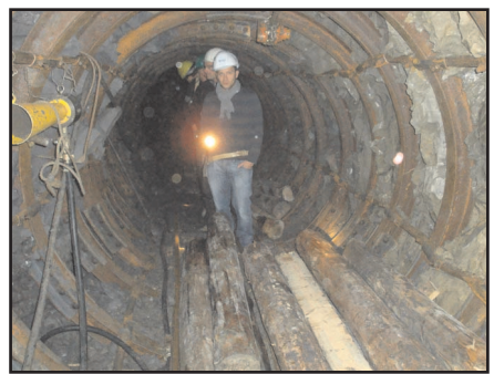
Ausgebaute Strecke im Tonwerk Klingenberg
