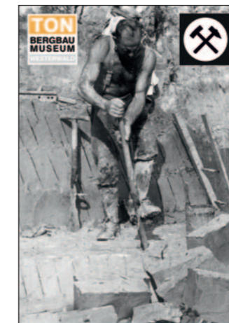
Schichtanlage »Gute Hoffnung« Der Tonbergbau im Westerwald ist seit 1890 die Schichtanlage »Gute Hoffnung« von der Firma Georg & Schneider übernommen, um die zu verfahren und als Betriebsstätte der Bergbaugeschichte des Westerwalds der Öffentlichkeit zugänglich zu machen. »Gute Hoffnung« gehört zu den Schichtanlagen mit Gattelförderung. Der Schacht ist 88 m tief, die Hauptfördererle liegt auf 25 m. Von 1922 bis 1970 wurde Tonuntertage gefördert, teilweise in zwei Schichten, mit insgesamt 20 Mann. Die moderne Flözzeile im Westerwald ist ein Werkstück in handwerklicher Qualität. Sie ist 1,20 x 2,40 m groß, hergestellt auf der G&S-Linie, die im August 2017 in Betrieb genommen wurde. IHK Koblenz • Blikk Produktionsstandort: Wied, im Sommer
