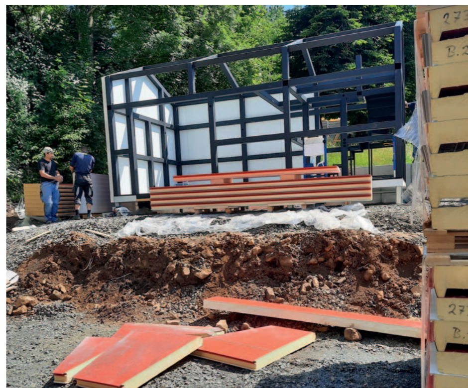
Drei Tiny Häuser entstehen gerade in Bad Marienberg am Rande des Kurparks, vorgesehen als Feriendomizil für Westerwald-Urlauber.
