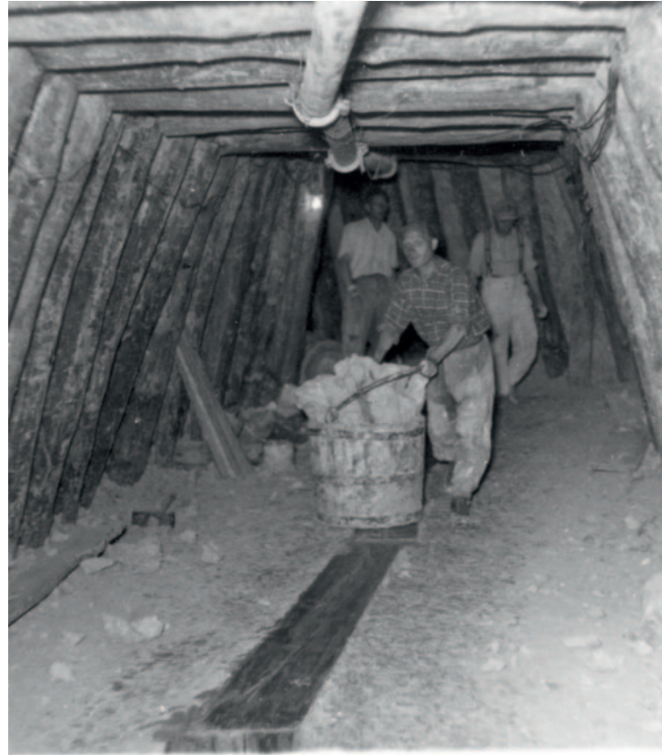
Untertägige Strecke mit Stempelausbau, ca. 1930
